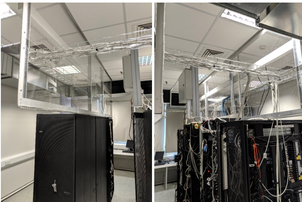
Εικόνα 1: Διαχωρισμός ψυχρού και θερμού αέρα με την χρήση plexiglass.
