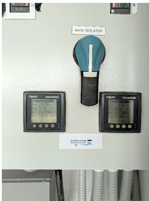
Εικόνα 5: Ο πίνακας με τους έξυπνους μετρητές κατανάλωσης για τα κλιματιστικά (ένας μετρητής ανά δωμάτιο).
